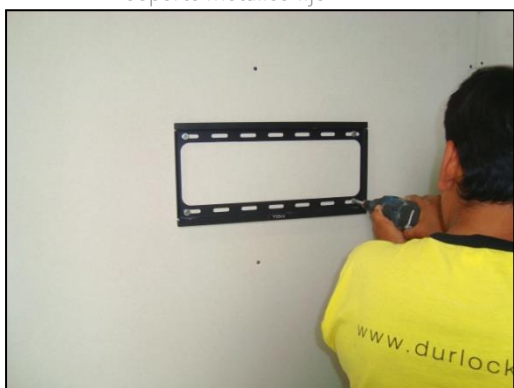
Soporte metálico fijo
